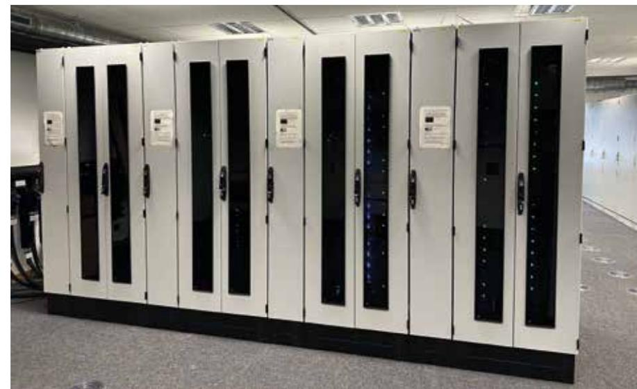
Abb. 1: wassergekühlte Schrankreihe im ESZ für High Performance Computing (HPC)
